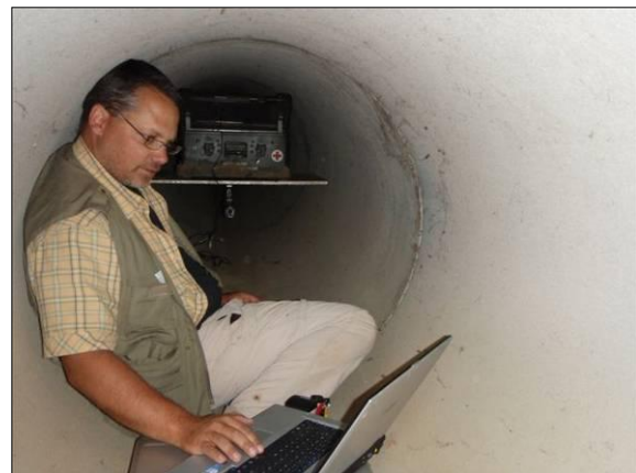
Abb. 5: Installation und Programmierung einer mobilen Aufnahmeeinheit in einem Röhrendurchlass an der A 71
